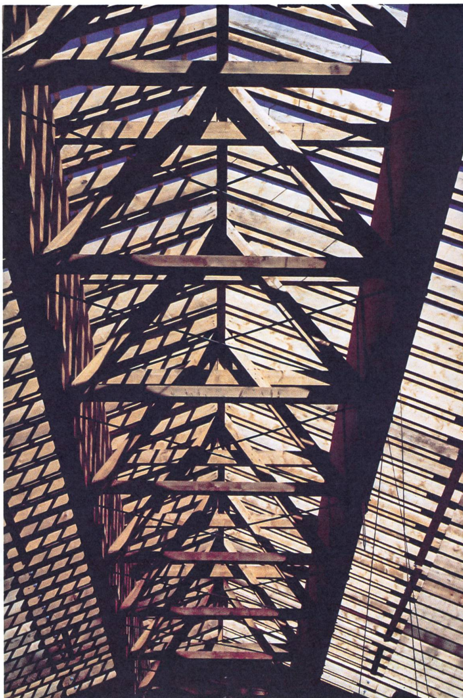
Les deux immenses poutres lamellé-collé, des traverses et des contre-fiches se réunissent avec la panne faîtière et des chevrons en une construction imposante.
