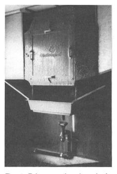
Fig. 1: Echangeur thermique à plaques ondulées, avec système d'écoulement de l'eau de condensation et de pulvérisation. Lieu: poulailler.
