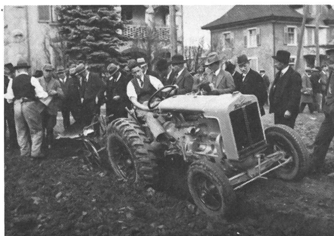
Bien que les premiers essais pour introduire le tracteur agricole en Suisse se situent au début de la première guerre mondiale, sa marche victorieuse ne débuta que vers 1955. Essai de charrue actionnée par tracteur lors de l'exposition de machines agricoles à Brougg AG en 1935.
