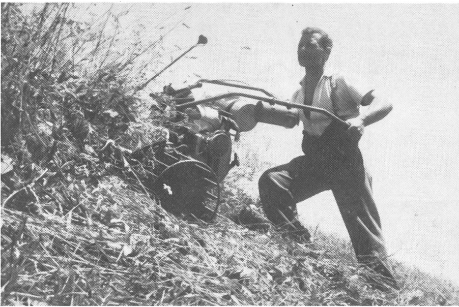
6: Les motofaucheuses de montagne légères et maniables ont permis le fauchage mécanique dans des pentes de plus de 80%.
