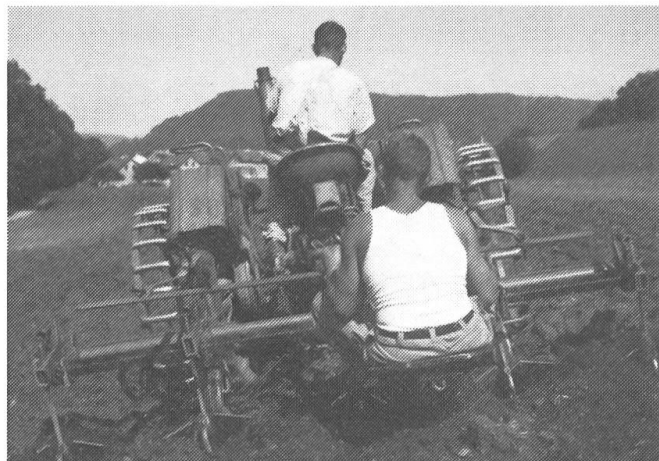
3: La question première, attelage trois points ou quatre points, a trouvé sa réponse dans les travaux sur terrains en pente. En raison de la mobilité latérale, l'utilisation sans accroc d'appareils polyvalents n'était possible qu'avec l'attelage trois points.
