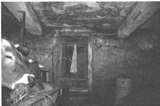
Défauts d'isolation et d'aération: dégâts dans un plafond en dur après 30 ans.
