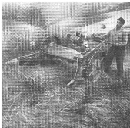
9: Motofaucheuse avec axe à portique et entraînement latéral de la lame, équipée de tôles à andains.
