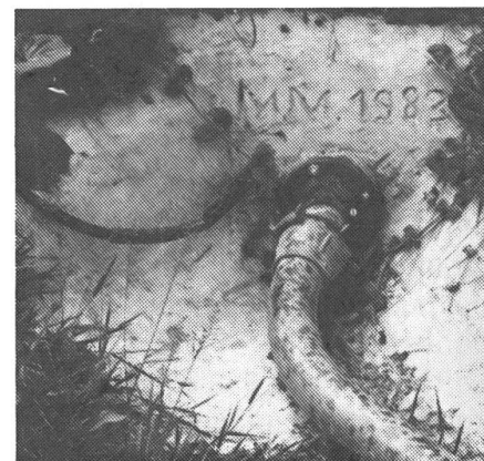
Fig. 10: Les coûts d'une installation en sous-sol sont plutôt justifiés s'ils peuvent être combinés avec l'abreuvement sur les champs (tuyau à gauche de la sortie de la conduite).
