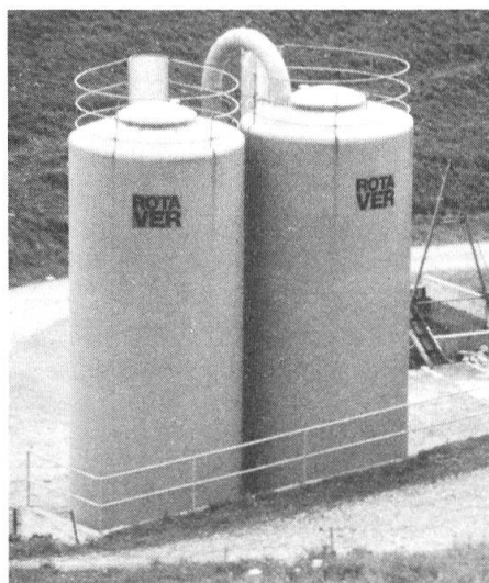
Installation de silo correcte: barrière et montée munie d'une rampe. Il est facile d'aérer un silo s'il comprend une soufflerie.
