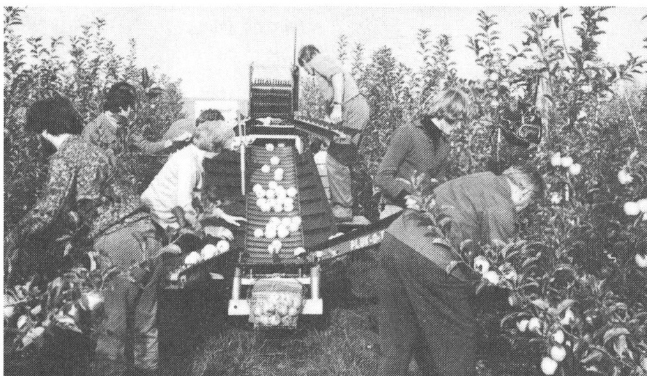
1 La machine de récolte de pommes hollandaise est surtout employée en France. Elle facilite avant tout le travail, mais dans nos conditions de récoltes échelonnées sur 2 à 3 périodes, elle n'apporte pas d'amélioration du travail. Pour assurer une certaine rentabilité il faut des cultures fruitières d'env. 20 ha.
