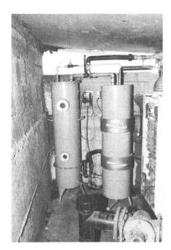
Fig. 4: Installation de désulfurisation avec 2 colonnes pour le nettoyage de 50 m³ de biogaz par jour.
