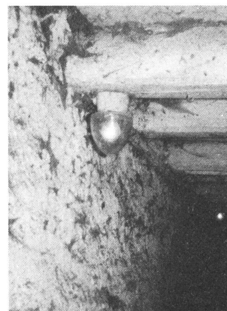
3: Deux lampes à incandescence de 60 Watt, espacées à raison de 6 à 10 m, fournissent un éclairage absolument insuffisant pour une étable de vaches laitières. Il convient d'ajouter qu'une salissure des lampes, murs et plafonds réduit considérablement l'efficacité du système d'éclairage.
