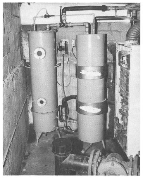
Fig. 2: Aspect d'une installation de désulfuration mise en pratique.
