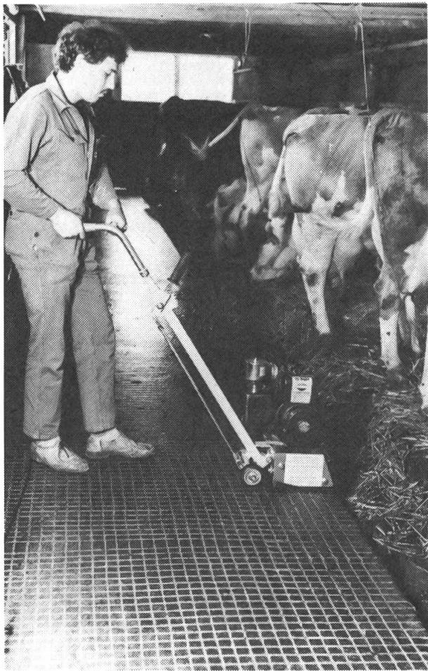
Pour éviter de glisser sur ces sols lisses, la surface peut être striée dans le sens de la longueur ou en croix avec la machine Von Arx FR-200 pour les traitements des surfaces.
