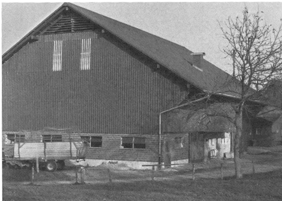
Fig. 2: La grange modernisée par Franz Arnold à Laubbach SG. On remarque l'ouverture admettant l'air entrant pratiquée dans le triangle du faîte et prévue pour alimenter le dispositif de séchage en grange comportant un capteur solaire.
