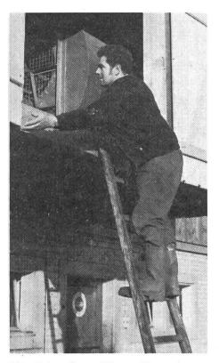
Fig. 5: Le dispositif monté au-dessus de la porte de l'étable permet l'amenée de l'air passant par le toit mais contribue aussi à l'insonorisation de l'installation.
