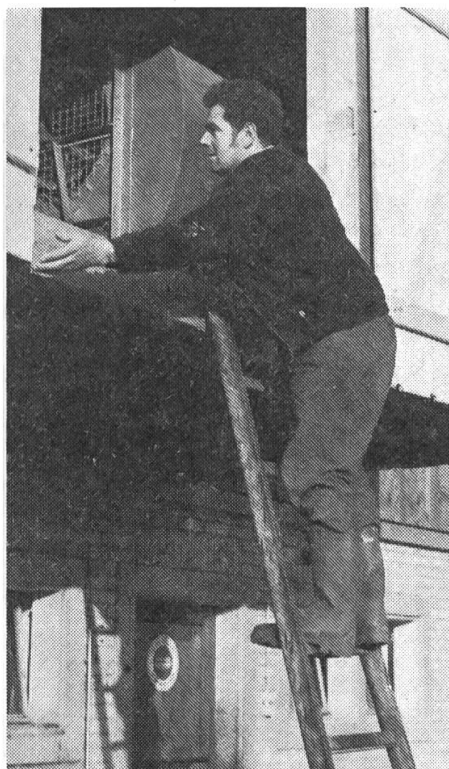
Fig. 5: Le dispositif monté au-dessus de la porte de l'étable permet l'amenée de l'air passant par le toit mais contribue aussi à l'insonorisation de l'installation.
