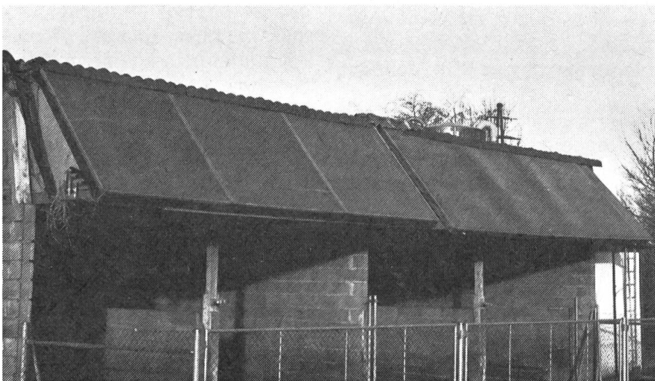
Fig. 1: Capteur solaire utilisé pour la préparation d'eau chaude soumis à des tests comparatifs pratiques entrepris par la Station de recherche de Tānikon (FAT).
