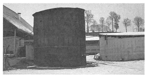
Fig. 2: Milieu: Le réacteur de biogaz isolé. A droite: le silo à purin fermenté, simultanément lieu de stockage pour le biogaz produit. A gauche: (sous l'avanttoit de la grange): la halle de machines en briques.
