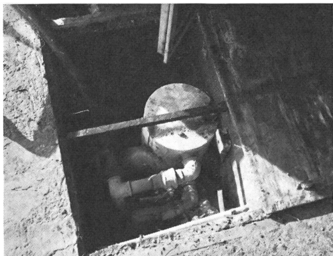
Fig. 2: Séparateur d'eau de condensation à conduite d'amenée et conduite de décharge.
