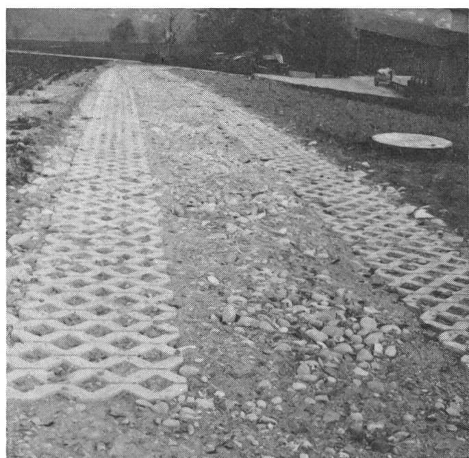
uniformité continue. Des types ondulés présentent des points de rupture potentiels qui peuvent causer des fractures très importunes. A part cela, des types absolument plats permettent de faucher l'herbe sans aucun problème.
