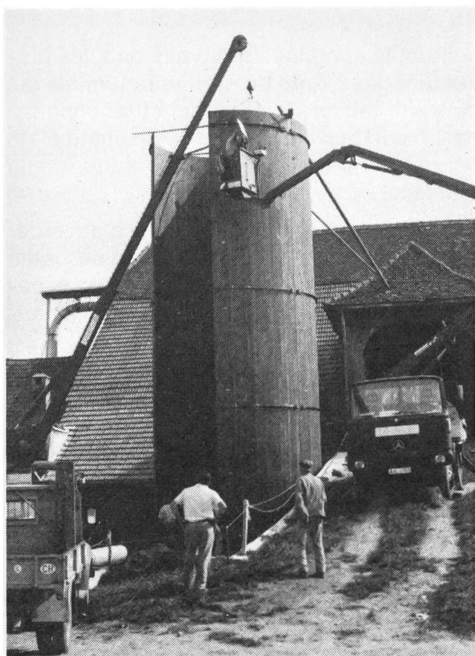
Grâce à l'emploi de dispositifs spéciaux, le silo en bois système Uhrle (mis en vente par l'entreprise Rotaver AG, 3432 Lützelflüh) peut être érigé dans un délai particulièrement court.
