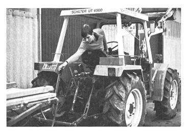
Fig. 1: Le frein de remorque avec le levier à main sur le timon du tracteur appartient-il au passé?
