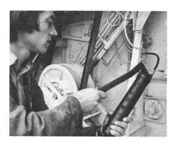
graissage complet selon le plan de graissage chasse une éventuelle eau de condensation et protège les paliers de la corrosion. Laissez maintenant la moissonneuse-batteuse tourner à mi-régime et contrôlez les paliers sur un éventuel échauffement. Suite à quoi, il s'agit de contrôler les tours du tire-paille, du batteur à battes et du vilbrequin des secoueurs (Fig. 3).
