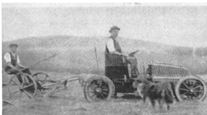
Machine de traction fabriquée avec une auto Cotteraux , prévue pour le remorquage de la faucheuse mécanique (1917 env.).
