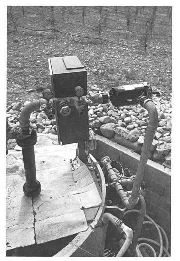
Fig. 5: Batterie de filtres et programmateur des valves de secteur d'une installation d'irrigation par goutte à goutte à Prangins VD.
