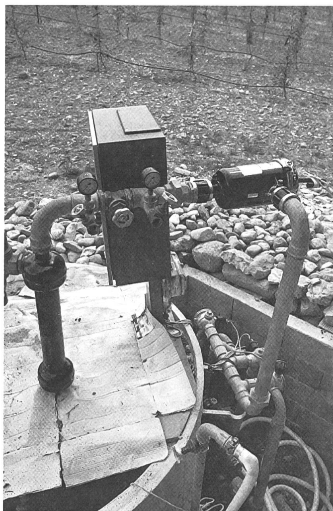
Fig. 5: Batterie de filtres et programmeur des valves de secteur d'une installation d'irrigation par goutte à Prangins VD.
