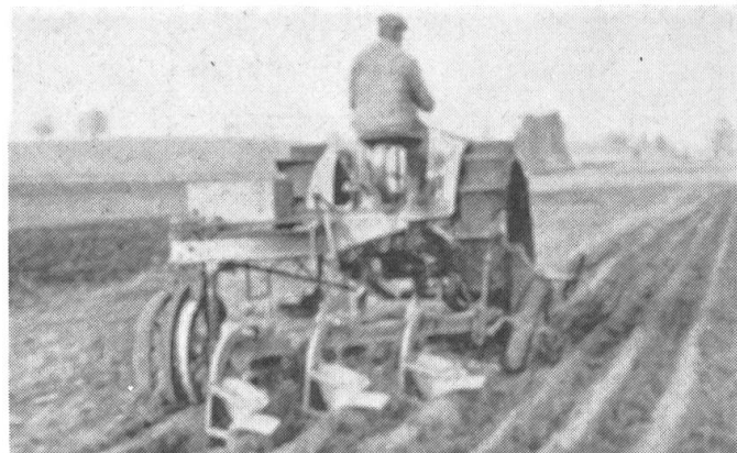
Motocharrue Winterthour (1918), 3 roues, constr. fabrique suisse de locomotives et de machines (SLM), Winterthour. Mot. à essence de 18 CV, 2 cyl. charrue Ott à 2 ou 3 socs.
