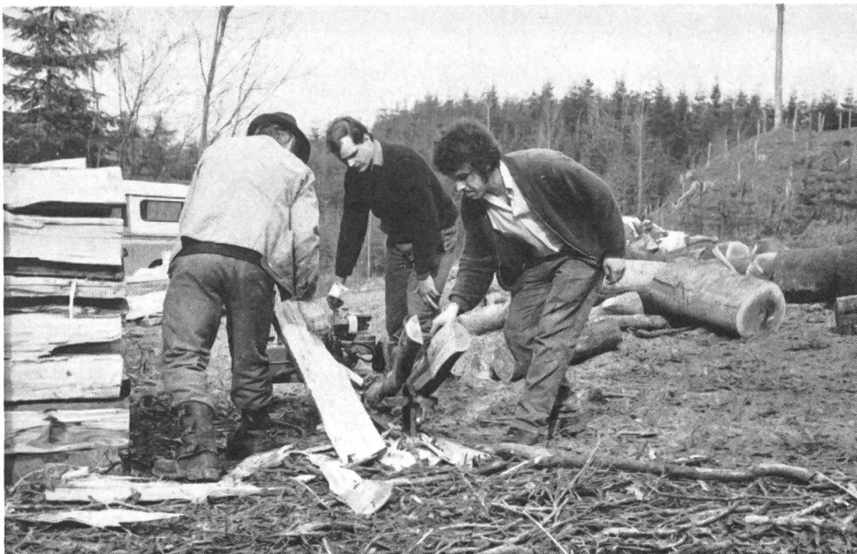
Fig 7: Cette fendeuse légère à travail horizontal et moteur incorporé a été placée directement devant la pile. Les lourds rondins (poids moyen 47 kg) on dû être amenés et placés sur la machine à la main. Le niveau de travail et le levier de commande sont placés extrêmement bas. Il en résulte beaucoup de travail en position courbée.
