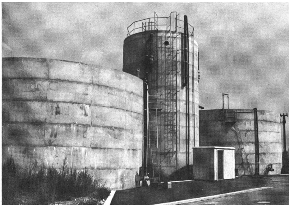
Fig. 3: Installation de production de biogaz comportant deux silos à purin.
