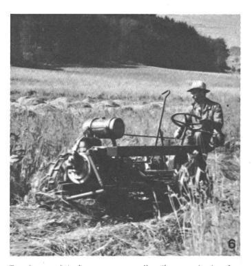
Faucheuse à trois roues avec direction sur toutes les roues (1929), un prédécesseur d'avant garde de la faucheuse à deux essieux Terratrac vendue aujourd'hui.
