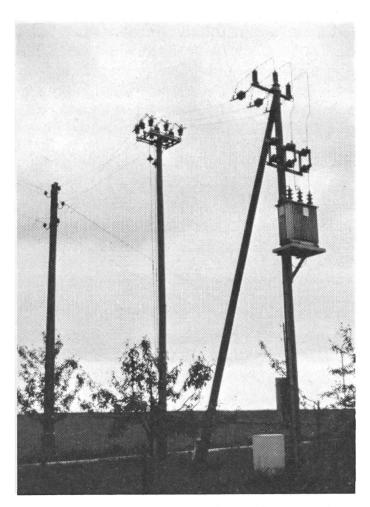
Fig. 1: Ligne aérienne et cabine de transformateur dans le voisinage d'une ferme isolée.
