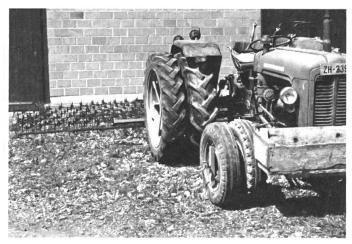
Fig. 2: MF à roues jumelées et masses d'alourdissement frontales remorquant une herse étrille de 6,5 m de large.
