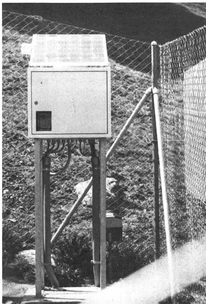
Fig. 4: Le transformateur au moyen duquel le courant continu est transmis à la pompe.
