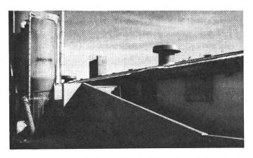
Fig. 2: Porcherie de la vallée du Rhin st. galloise équipée de 2 échangeurs de chaleur RECUMAT combinés avec 2 ventilateurs FRISTAMAT correspondants.
