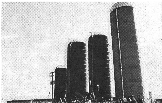
Fig. 1: Le propriétaire de cette exploitation a suivi l'évolution de la construction. Tout à gauche, on reconnaît un silo en bois. Suivent deux silos en métal et tout à droite un immense silo en béton d'une contenance d'environ 1800 m 3 . Et pour obtenir une capacité encore supérieure, il est prévu d'en construire un autre en matière plastique.
