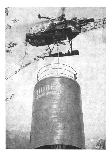
Fig. 2: Transport par hélicoptère sur un site difficilement accessible.
