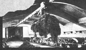
par Landtechnik et lui a également commandé un pont roulant pour le stockage et la reprise du fourrage.
