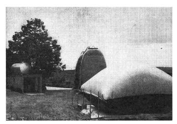
Fig. 2: Les deux caissons de fermentation. Le local dit technique est situé dans le garage. Le réservoir de pression placé sur le garage n'est pas en usage; il faisait d'abord office de régulateur de pression. Au premier plan, on remarque le récipient à gaz gonflable.
