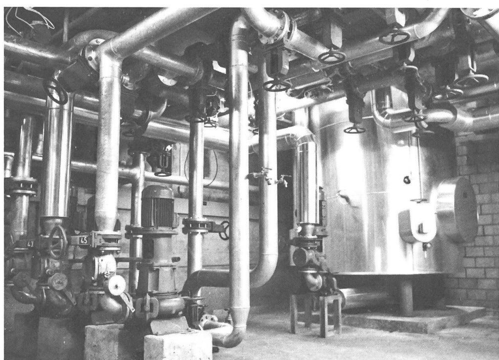
Dans la cave de la tuyauterie: On voit la substructure du réacteur ainsi que la pompe d'alimentation du digesteur et les conduites de circulation du système de putréfaction.
