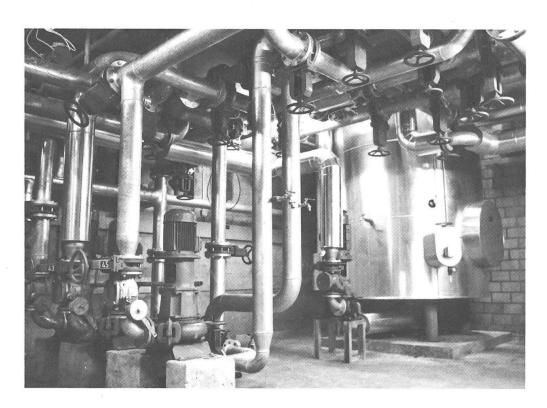
Dans la cave de la tuyauterie: On voit la substructure du réacteur ainsi que la pompe d'alimentation du digesteur et les conduites de circulation du système de putréfaction.
