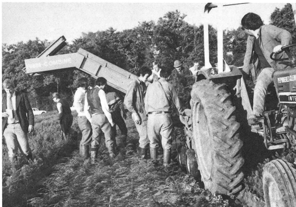
Fig. 1 : Des spécialistes provenant de nombreux pays du monde entier sont venus en Suisse pour examiner le dernier modèle de l'arracheuse forestière Bärtschi. Cette machine extirpe notamment des plants de pépinière en réduisant fortement le taux usuel d'endommagements de racines. Elle a été dérivée de l'arracheuse de pommes de terre Famos.
