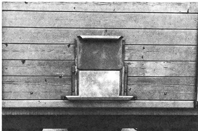
Fig. 11 a: Une petite trappe avec seuil ne peut convenir que pour les céréales et autres produits analogues.
