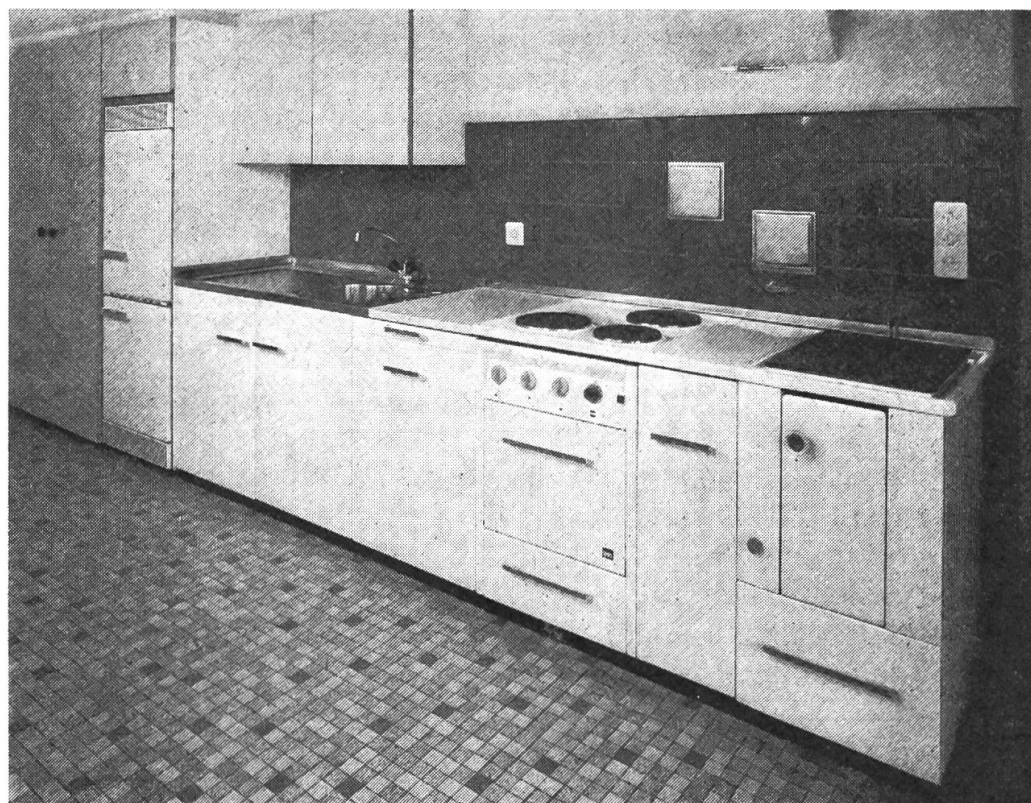
Fig. 1: Cuisinière conçue pour une consommation économique du bois et combinable avec un poêle électrique auxiliaire.
