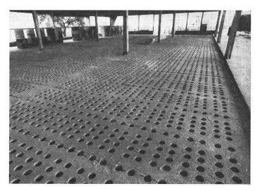
Les gîtes perforés consistent en dalles de béton livrables en unités de 2-3 m de long et de 55 cm de large. Les perforations réparties régulièrement occupent 20% de la surface du plancher posé.
