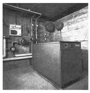
Fig. 3: Pompe à chaleur Hoval «WW-Automat» sans chauffe-eau. Prévue pour mise en valeur de chaleur provenant de cours d'eau ou de collecteurs souterrains ou solaires. Régime de 19-46 kW.
