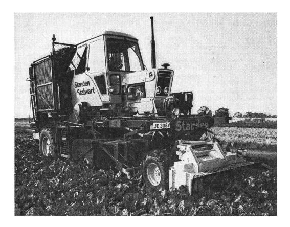
Cette récolteuse auto-propulsée de betteraves sucrières, mise au point en Grande-Bretagne, a son propre réservoir et, au dire du constructeur, elle permettrait de produire une récolte plus propre que toute autre machine existante. Appelée la Standen Stalwart, elle est prévue pour travailler avec un seul homme et peut récolter simultanément deux ou trois rangées; elle peut nettoyer jusqu'à 25 tonnes de betteraves à l'heure.
