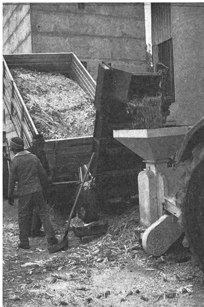
Fig. 4: Le mélange de grains / rafles est broyé à l'aide d'une machine stationnaire.
