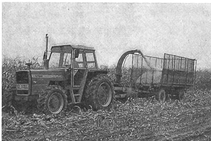
Fig. 7: Le hache-paille à couteaux, muni d'un recutter offre le même produit, du point de vue contenu de fibres (9–11%), mais avec des spathes complètement hachées. Le hachage des spathes exige une forte puissance du tracteur; c'est la raison pour laquelle même avec des tracteurs de la catégorie des 100 kW et avec un dispositif cueilleur à 2 rangées, on n'obtient qu'une capacité de surface d'environ 20 ares à l'heure.
