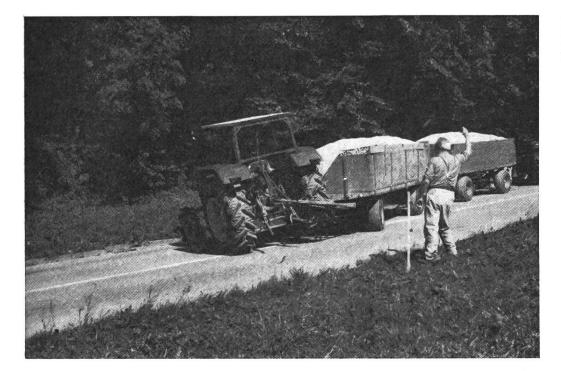
Les conséquences avec remorques au pouvoir de freinage insuffisant.
