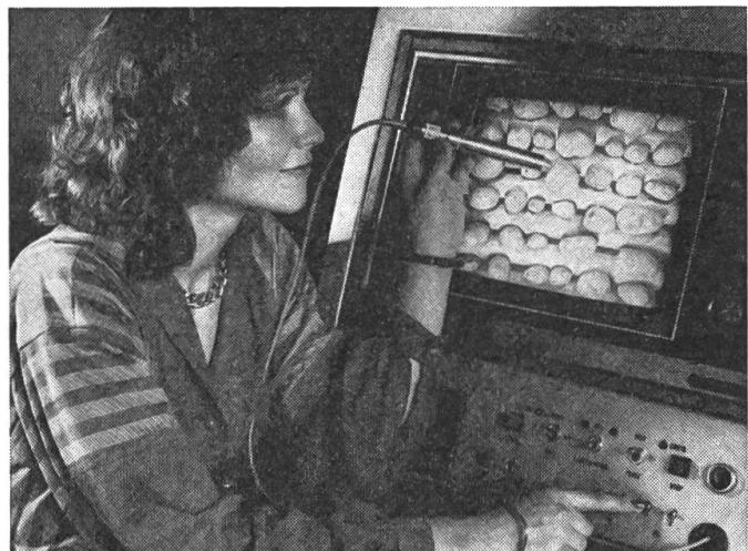
Lorsqu'un légume avarié apparaît sur l'écran, l'opératrice le marque à l'aide de la sonde pour qu'il soit mis au rebut. Lorsque cet instrument sensible à la lumière et aux vibrations touche l'image, un signal est envoyé à l'unité de commande qui actionne pneumatiquement des doigts de rejet montés sous le convoyeur. Les produits indésirables sont déposés sur un autre convoyeur placé le long du séparateur.
