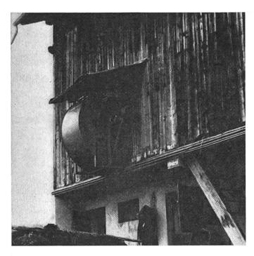
Fig. 4: Exemple à ne **pas** suivre: l'air rendu humide par la proximité d'une fumière sera immanquablement soufflé dans le tas de foin par le ventilateur.
