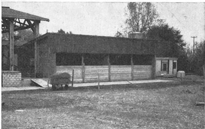
Fig. 4: La porcherie ouverte est orientée vers le sud. Après enlèvement des plateaux de bois garnissant le fond des boxes, un chargeur frontal peut être mobilisé pour l'évacuation du fumier.
