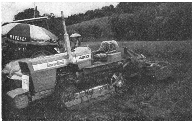
Fig. 1: Tracteur à chenilles de poids moyen avec herse rotative et attelage trois-points.
