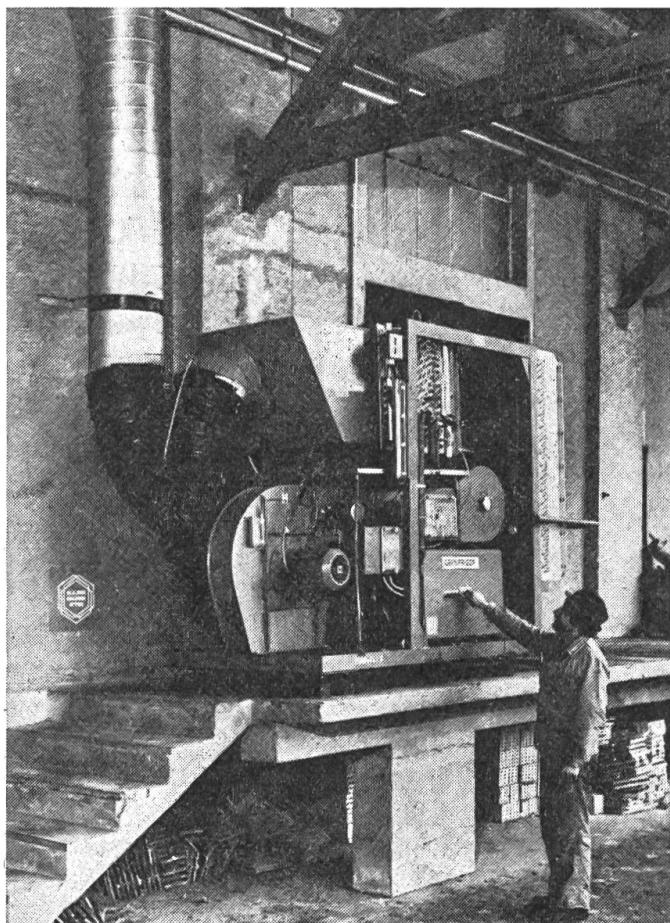
Le 100e «*Granifrigor*» livré en Suisse a été mis en service récemment dans les Huileries SAIS, à Horn. Cet appareil conçu et mis au point par *Sulzer/Escher Wyss* est à même de réfrigérer entre 110 et 150 tonnes de semences oléagineuses par jour.
