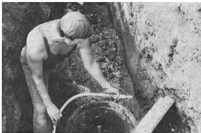
Fig. 1: Tête d'eau à injection indépendante que l'on pousse en avant dans les tuyauteries.
