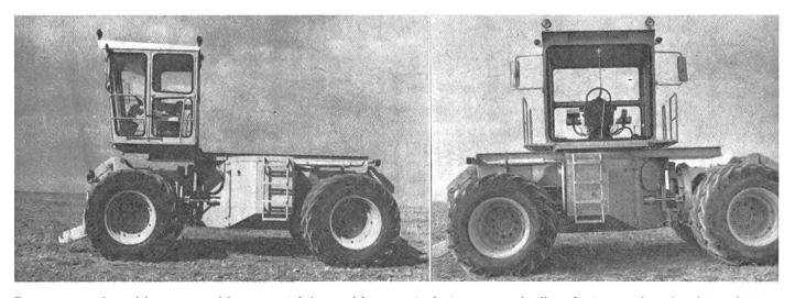
Pour passer la cabine en position avant à la position centrale transversale, il ne faut pas plus de cinq minutes. L'échelle de montée est fixée (de part et d'autre) sur le réservoir pivotant du fluide des transmissions. De part et d'autre du siège sont placés les boîtiers de commandes.
