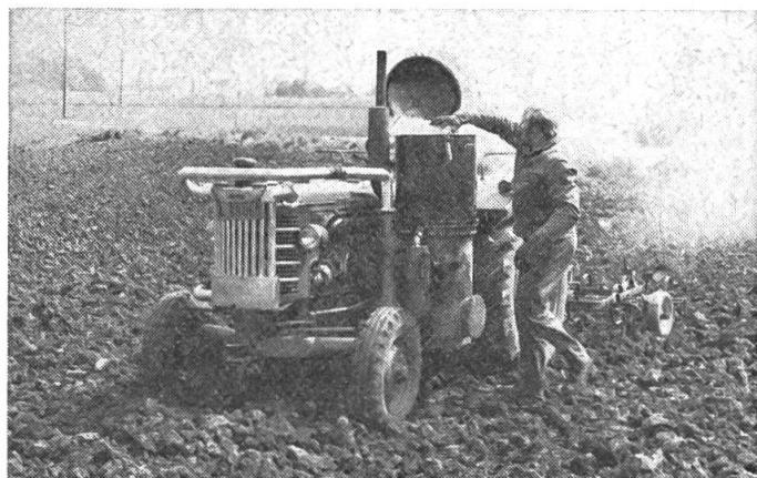
**Installation pour la production de carburant mixte (gasoil / gaz de bois)**
