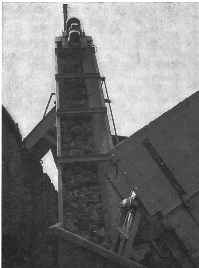
Fig. 2: Elévation des betteraves sucrières, depuis la trémie de réception, par le transporteur à vis sans fin. Puis élimination des matières et corps étrangers à travers la grille à barreaux et déversement des betteraves sur le wagon.
