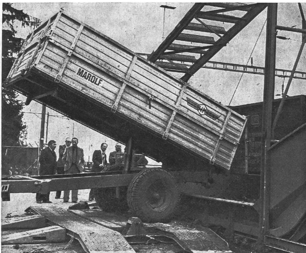
Fig. 2: Remplissage de la trémie d'alimentation de l'installation par une remorque à caisse basculante. A gauche, élévateur-basculateur prévu pour les re- morques ordinaires.
