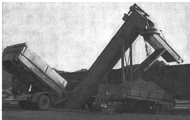
Fig. 1: Vidage d'une remorque basculante chargée de betteraves sucrières, par le fond mouvant à cornières, dans la trémie de réception. A droite, élimination des matières et corps étrangers (terre, pierres, feuilles) à travers une grille à barreaux, puis chargement des betteraves sur le wagon. On distingue également l'évacuation des matières et corps étrangers par le toboggan et leur chute dans une autre remorque.
